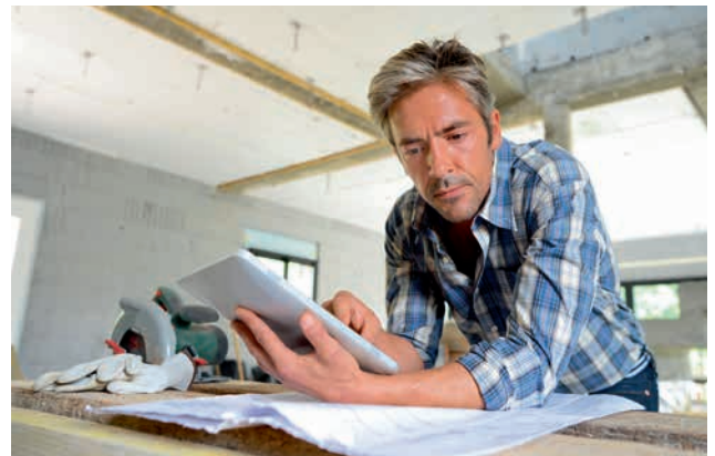
1 | Tablets und Smartphones sind auf der Baustelle praktisch, jedoch sollte der Datenschutz dabei nicht außer Acht gelassen werden.
